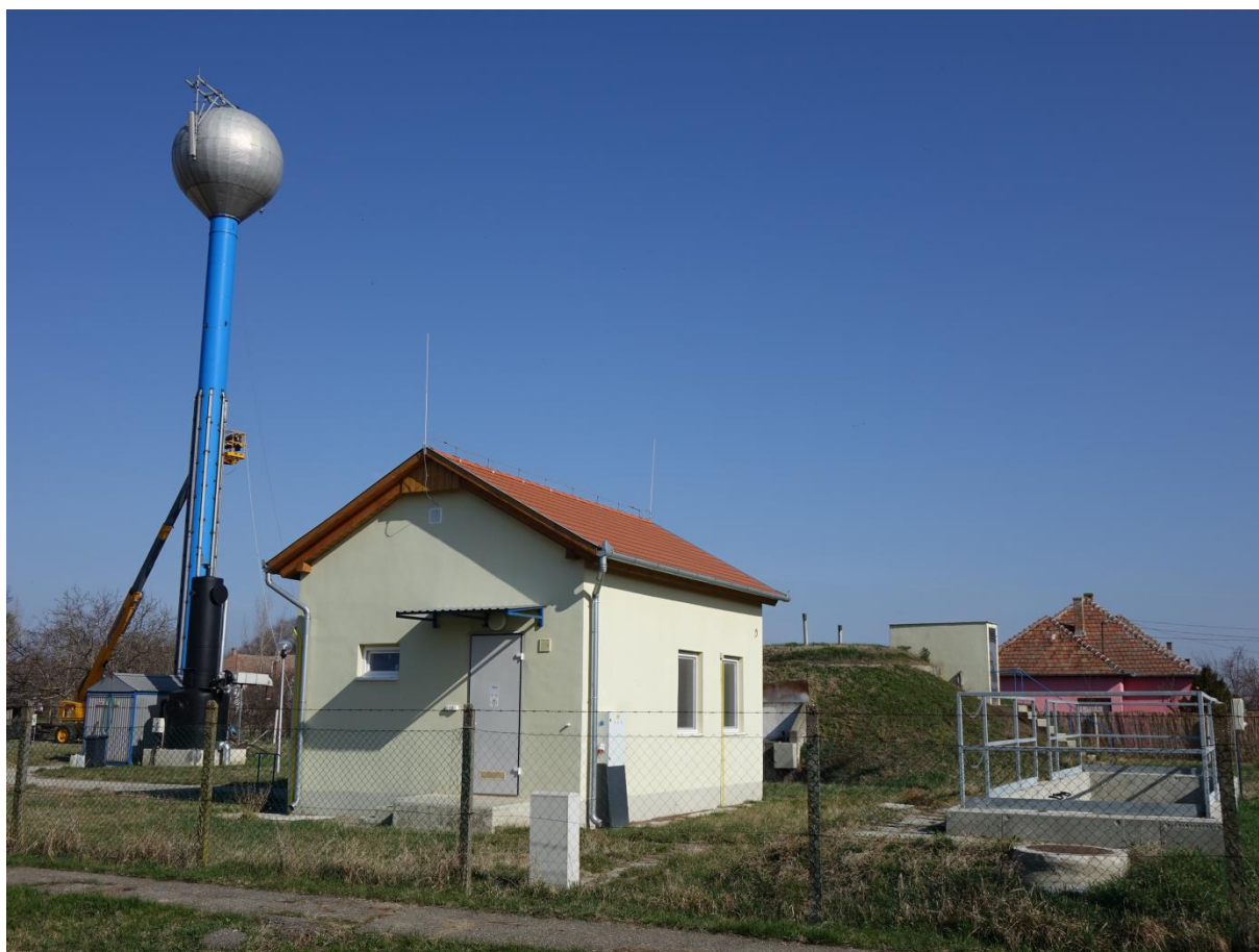
A mezőhéki vízműtelep
